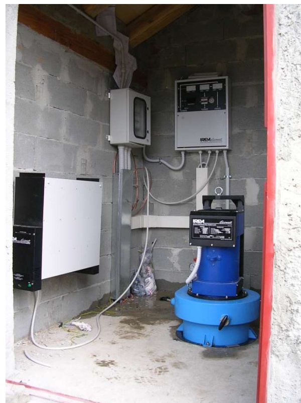
ペルトンタービン 左中央部 白箱は空気放熱抵抗とレギュレーター
